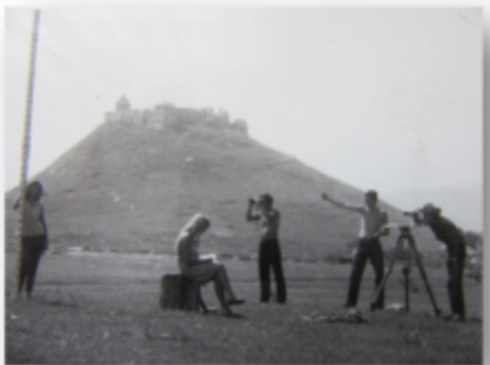
Mérőasztalos topográfiai felmérés
