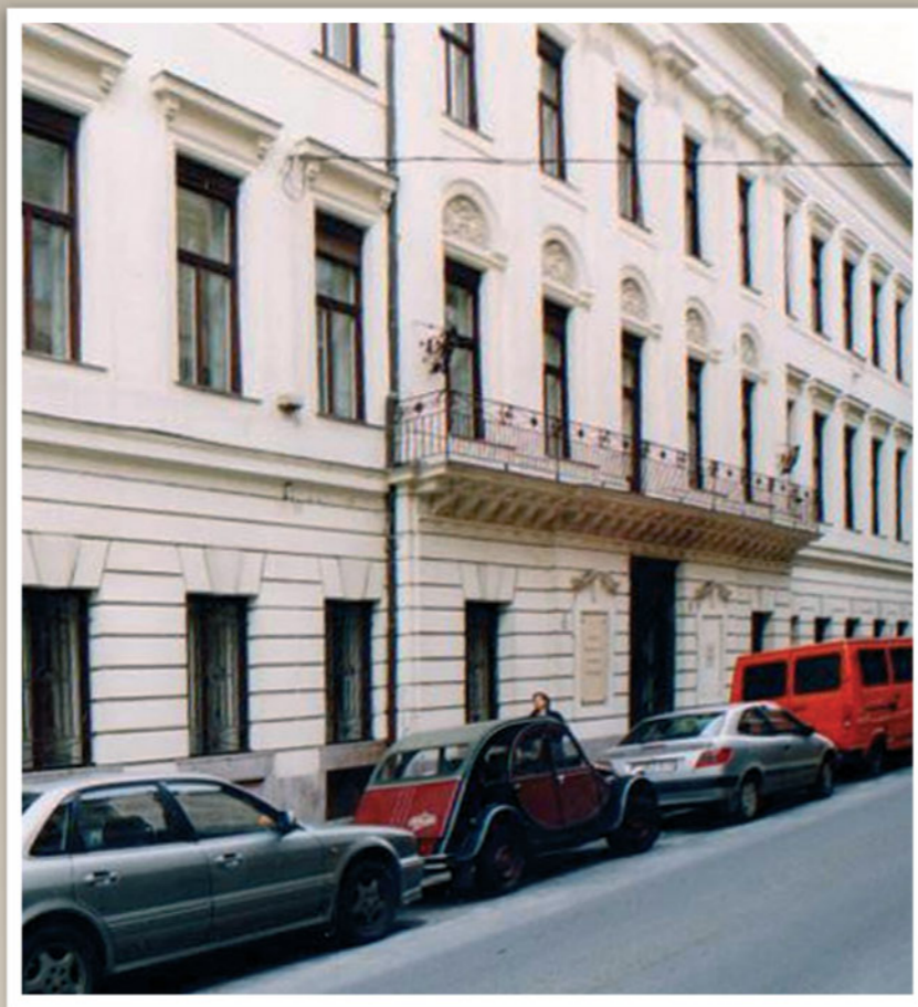
A Nádor utca 7, ahol a B1 építése kezdődött és az M-3 megszületett.
