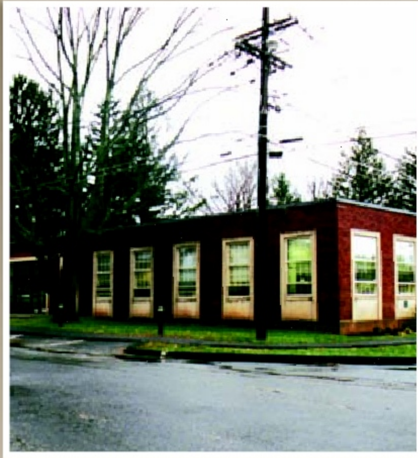
Az IAS gépet fejlesztő, régi laboratórium épülete, ma óvoda
