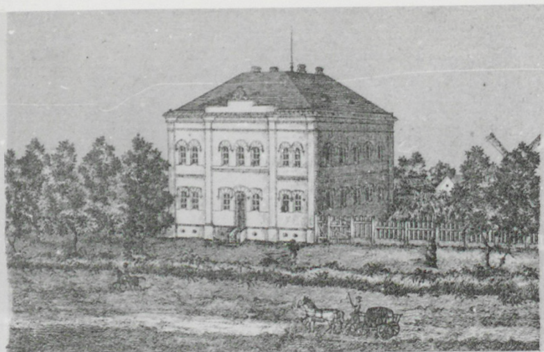
ORSZÁCOS CAZDASÁCI TANINTÉZET BELSŐ ÉPÜLETE.
