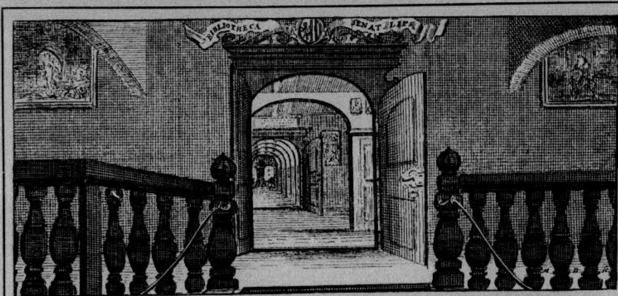
Leipziger Stadtbibliothek. Eingang des ehemaligen Bibliotheksaales im Zeughause. 1711.
